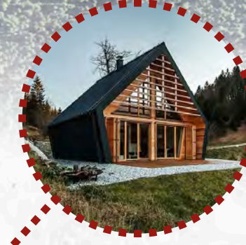
EDIFICI CENTRAL DE SERVEIS
