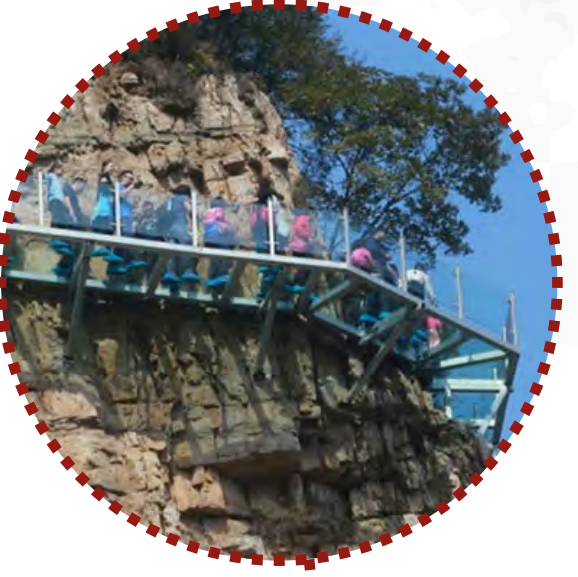
PASSARELLA DE VIDRE
