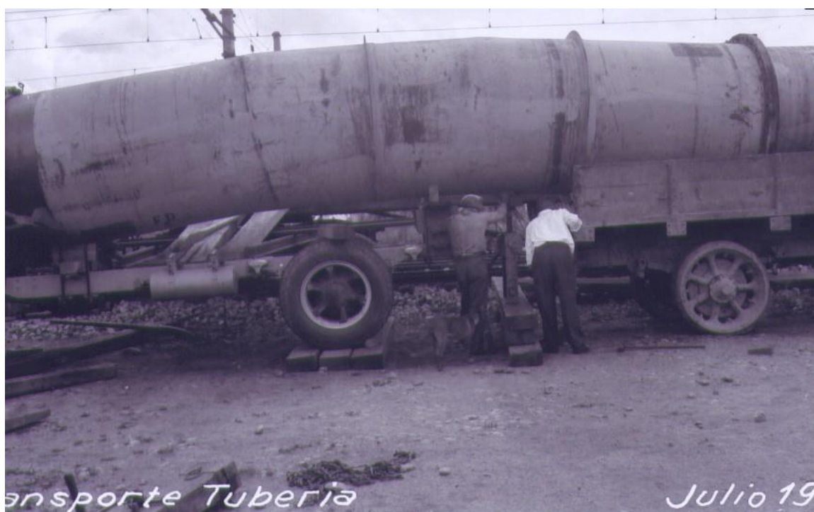
Transport de les canonades. Estació de tren de Puigcerdà, Juliol 1933
