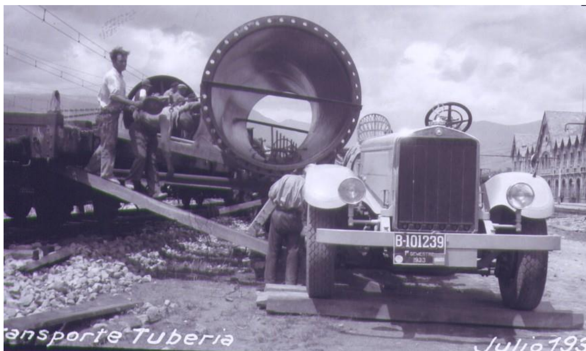
Transport de les canonades. Estació de tren de Puigcerdà, Juliol 1933
