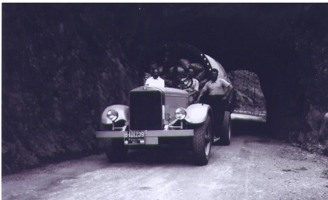
Transport de les canonades al túnel de Martínet, juliol 1933
