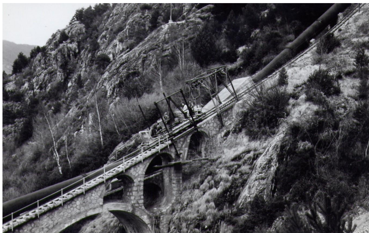
Muntatge de les grues noves del cable del funicular
